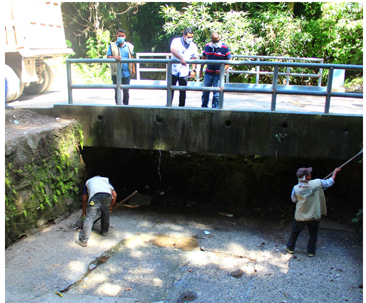
TRABAJOS DE MANTENIMIENTO EN PUENTE DEL SECTOR ERMITA
