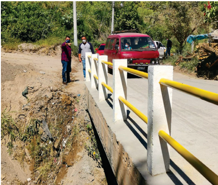
REPARACIÓN DE PUENTE EN SECTOR UNIDO
