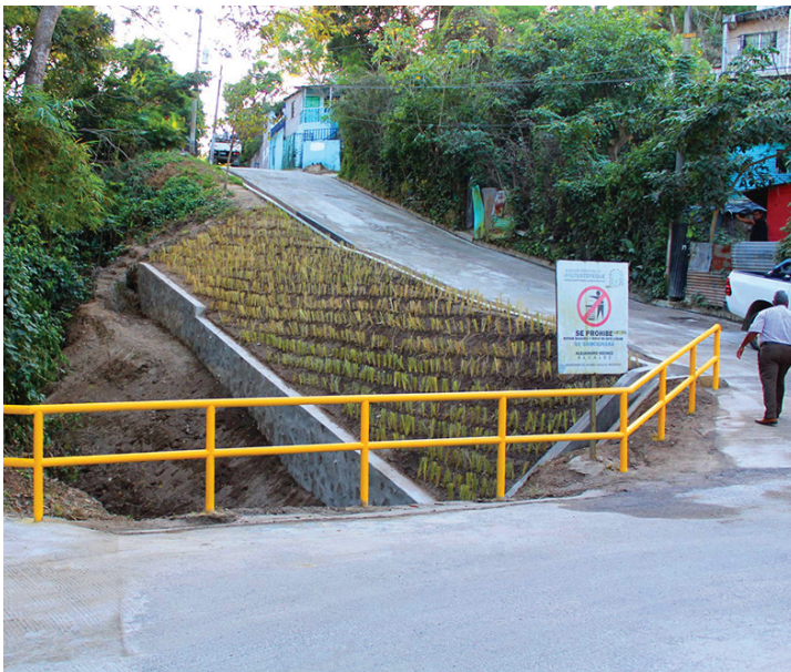
REPARACIÓN DE PUENTE EN COLONIA ROSATH
