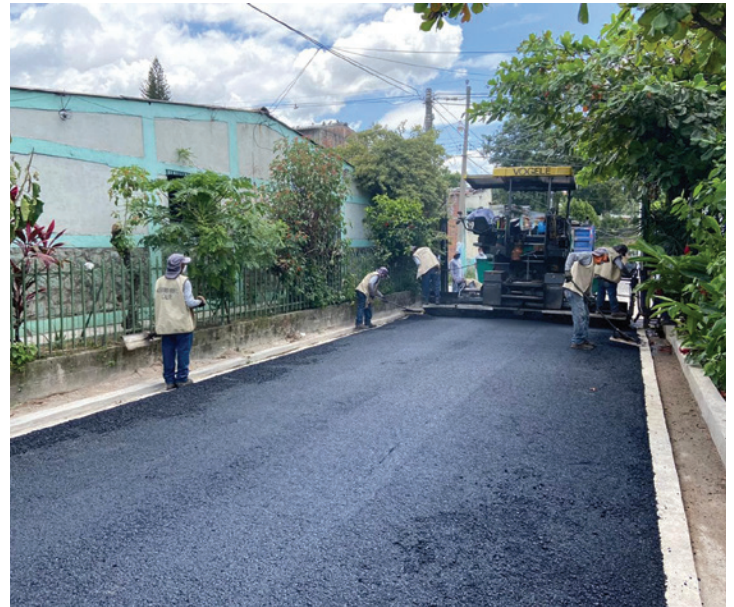
CONSTRUCCIÓN DE CALLE EN PASAJE 1 DE LA COLONIA ASCENSIÓN
