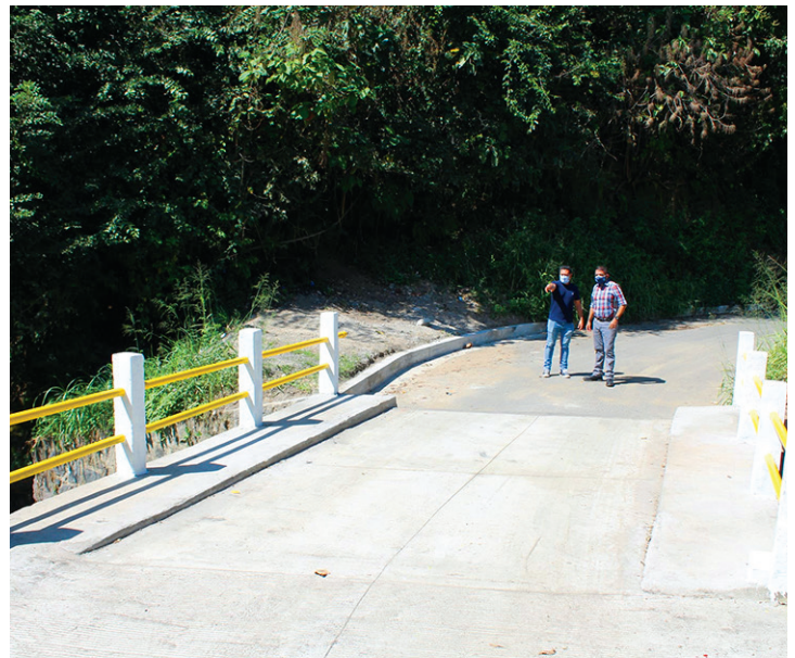
REPARACIÓN DE PUENTE EN CALLE A CEMENTERIO
