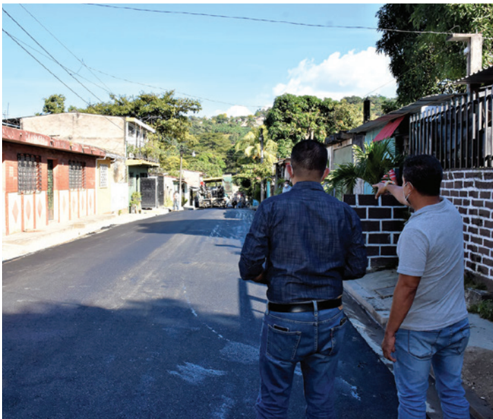
CONSTRUCCIÓN DE CALLE EN PASAJE 4 DE LA COLONIA SANTA RITA 2 EN ZONA CALLE A MARIONA
