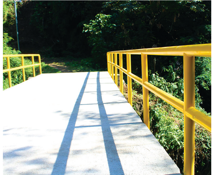
REPARACIÓN DE PUENTE EN COMUNIDAD CRISTO REDENTOR
